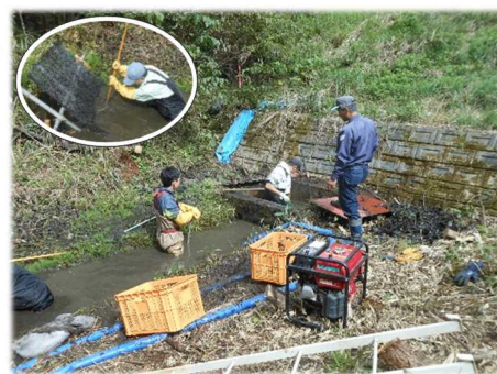
樋門出口の作業の様子
