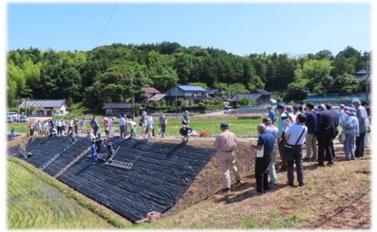
べた～とシート敷設の様子
