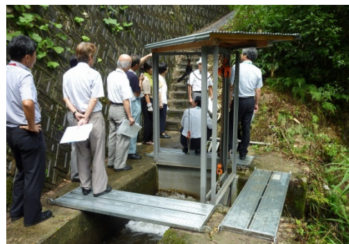
水路水門の改修現場
